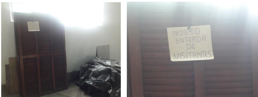
Fig. 48 Área interna: Detalhe Texto informativo - placa de restrição de acesso
