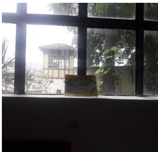
Fig. 44 Área interna: Textos informativos - placa de restrição comportamental
