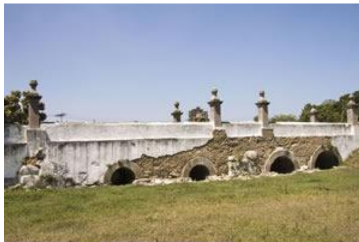
Vista lateral da ponte
