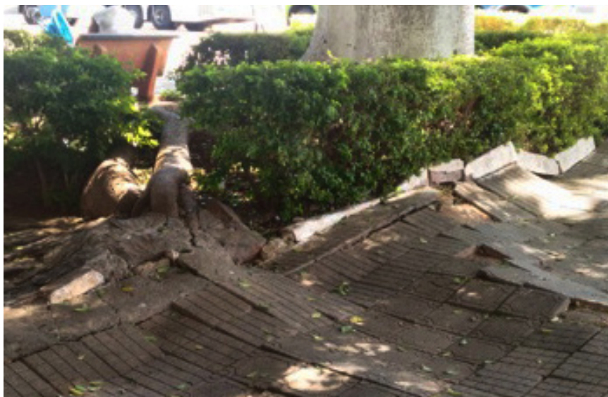
Il. 3: levantamento de calçadas e meio fio por raízes de figueira.
