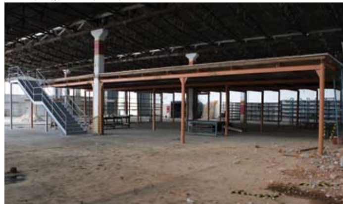
Interior do edifício, em ângulo parecido ao da fotografia de 2007, mostrando a escada e o mezanino sem entulhos.
