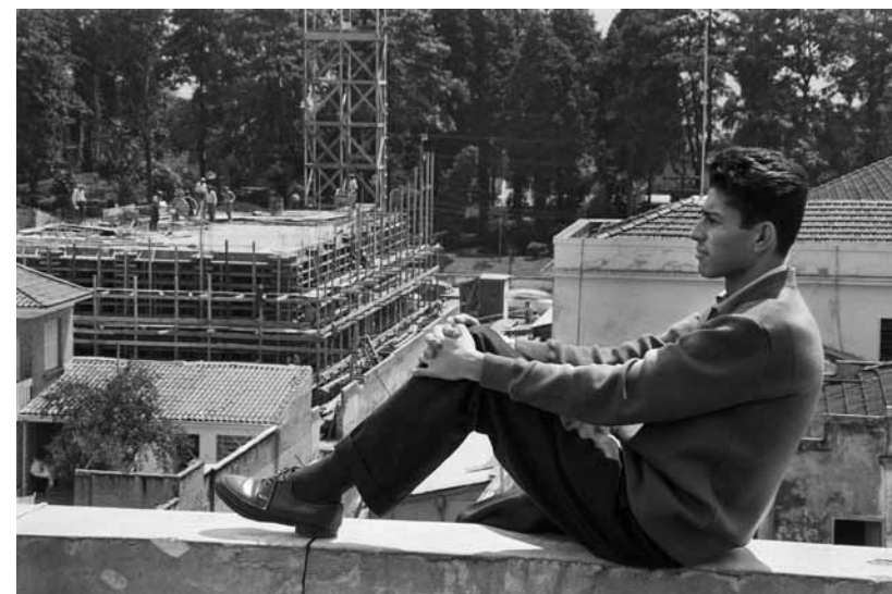
O fotógrafo Raymundo Lessa de Mattos em 1959, tendo ao fundo o edifício onde se instalariam as rádios Tupi-Difusora, em fase de construção.
