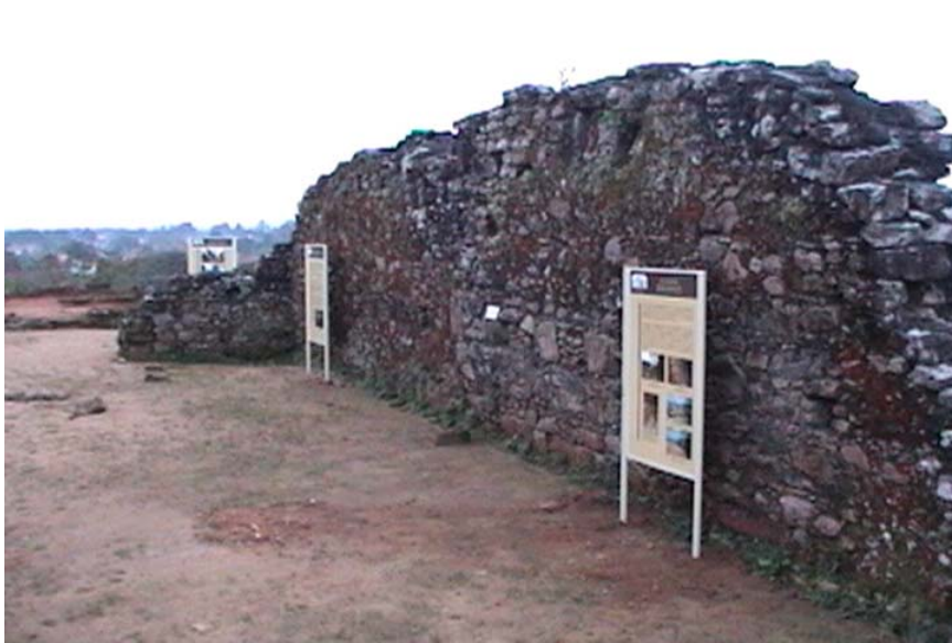
Fig. 31: Interior da ruína da igreja, nave central, com alguns expositores
