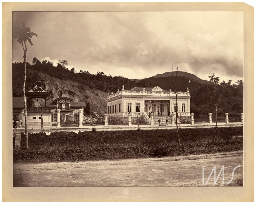
Figura 17 - Residência do Barão do Catete, 1870, Revert Klumb
