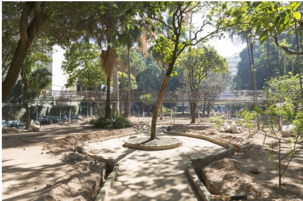
Figura 20: Valas de passagem das redes de infraestrutura passando pelos canteiros do Jardim
