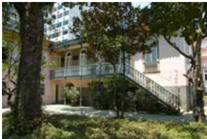
Fig. 7 - Varanda engastada na face posterior.
