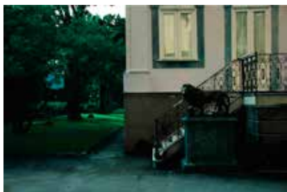
Fig. 6 - Varanda engasta na fachada frontal.
