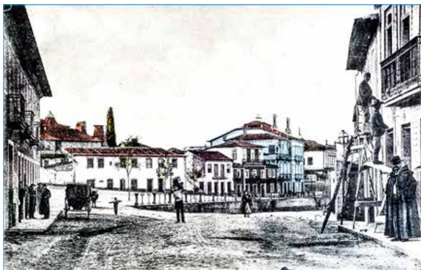
Fig. 3 – Cartão postal Fafe no início do sex XX. A casa materna de Albino ao fundo, ladeada pelos sobrados de Fortunato Jose de Oliveira, sendo as edificações mais altas.
