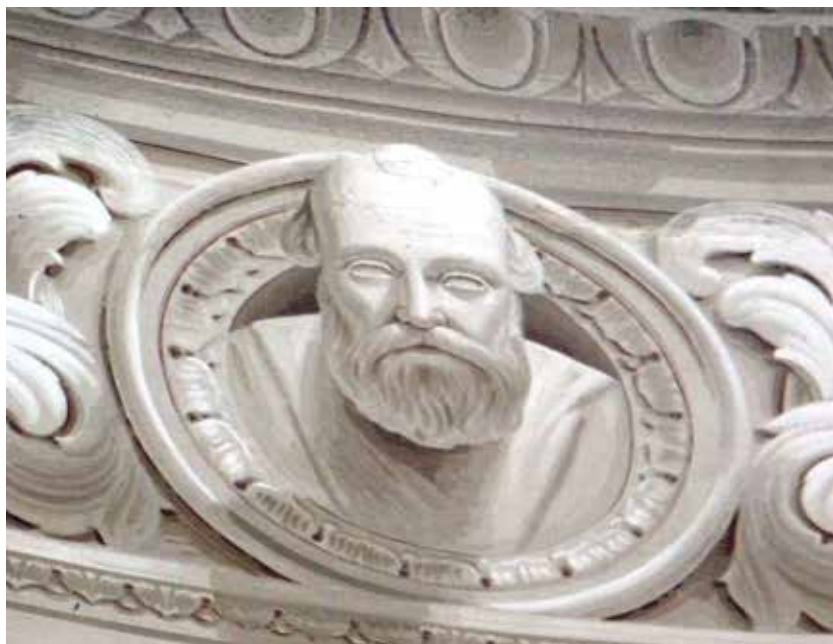
Fig. 9 – Palácio Burnay, Lisboa, pormenor da cimalha da caixa da escada, medalhão com busto representando possivelmente Henri Burnay, fotografia de Isabel Mendonça.
