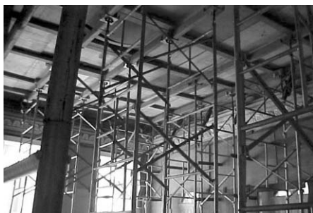
Fig. 7 – Vista geral do teto escorado
