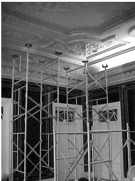
Fig. 5 – Início do escoramento da Sala Federação – montagem das torres
