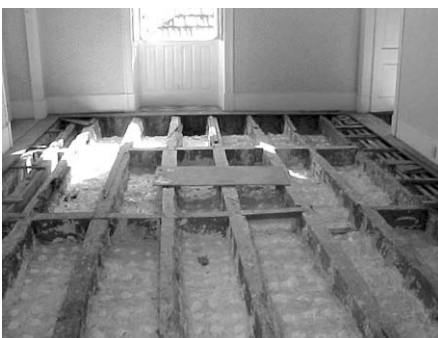
Fig. 18 - Vista geral do forro concluído
