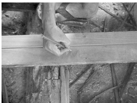
Fig. 9 – Identificação das tábuas retiradas
