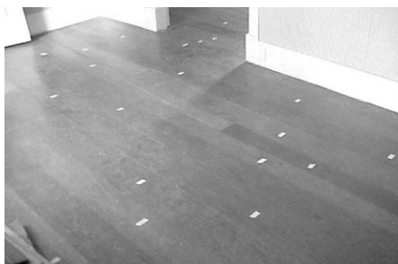
Fig. 8 – Mapeamento do piso
