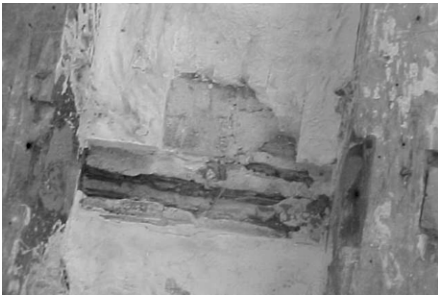
Fig. 11 - Detalhe de forro e camada de gesso
