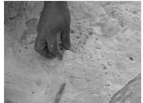
Fig. 16 - Ancoragem dos fios de nylon para consolidação do estuque
