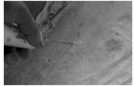
Fig. 13 - Aplicação de resina
