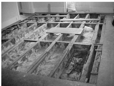
Fig. 10 – Visão geral do piso retirado
