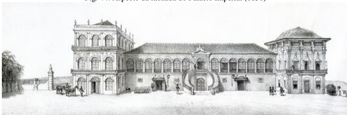
Fig. 44: Aspecto da fachada do Palácio Imperial (1831)
