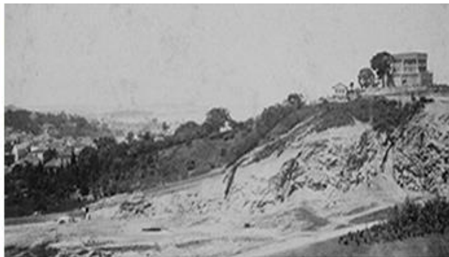
Fig. 86: Reservatório Pedro II no alto do morro do Barro Vermelho, São Cristóvão
