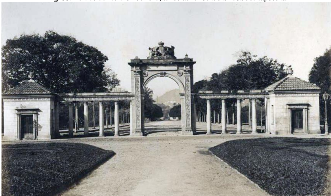
Fig. 33: Pórtico de Northumberland, tendo ao fundo a alameda das sapucaias
