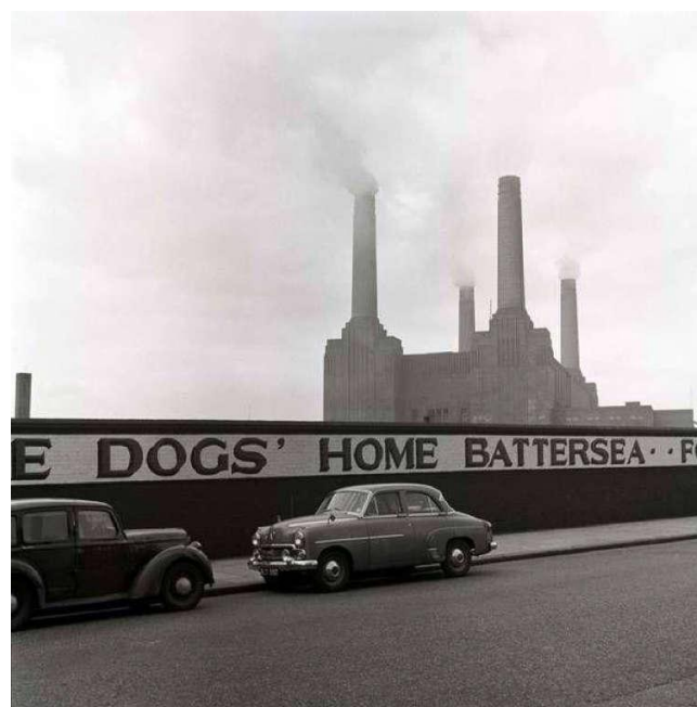
Figura 91 - Antiga estação de energia com as quatro chaminés.
