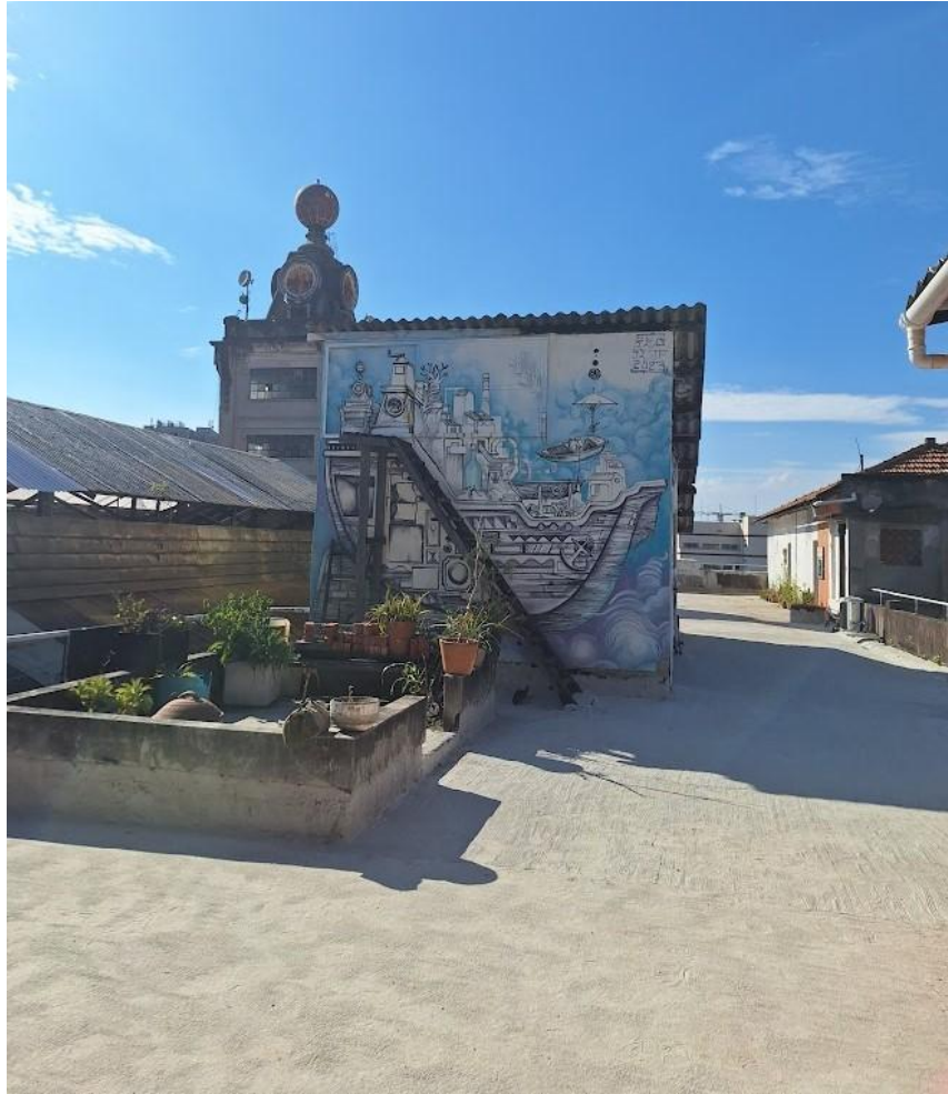
Figura 60 – Imagem do 6º andar com o terraço descoberto e a torre do relógio.
