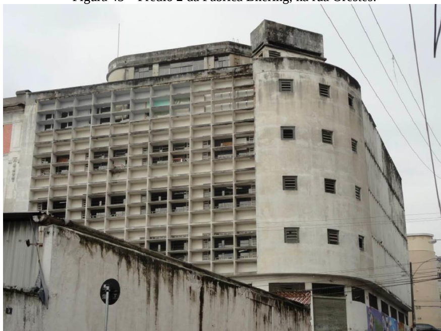
Figura 43 – Prédio 2 da Fábrica Bhering, na rua Orestes.
