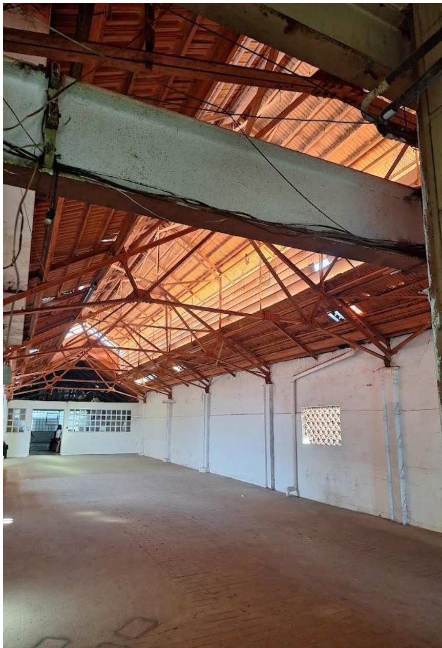
Figura 57 – Área no 5º andar com estrutura metálica de sustentação do telhado a vista.
