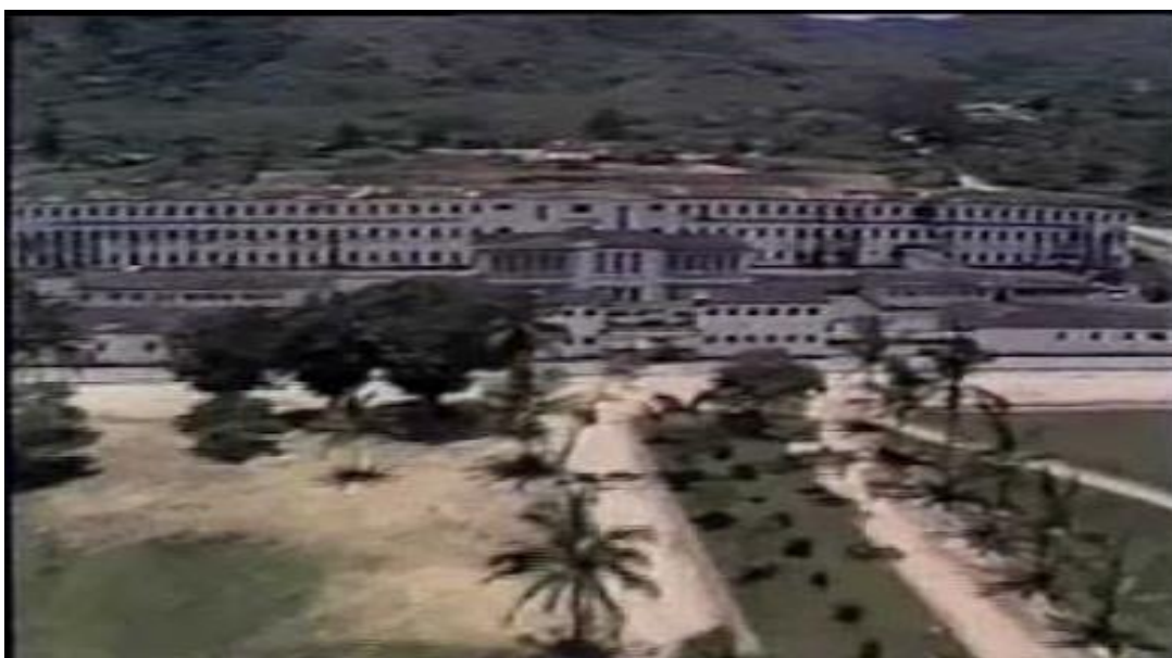
Figura 12 – Colônia Correcional de Dois Rios – presídio da Ilha Grande
