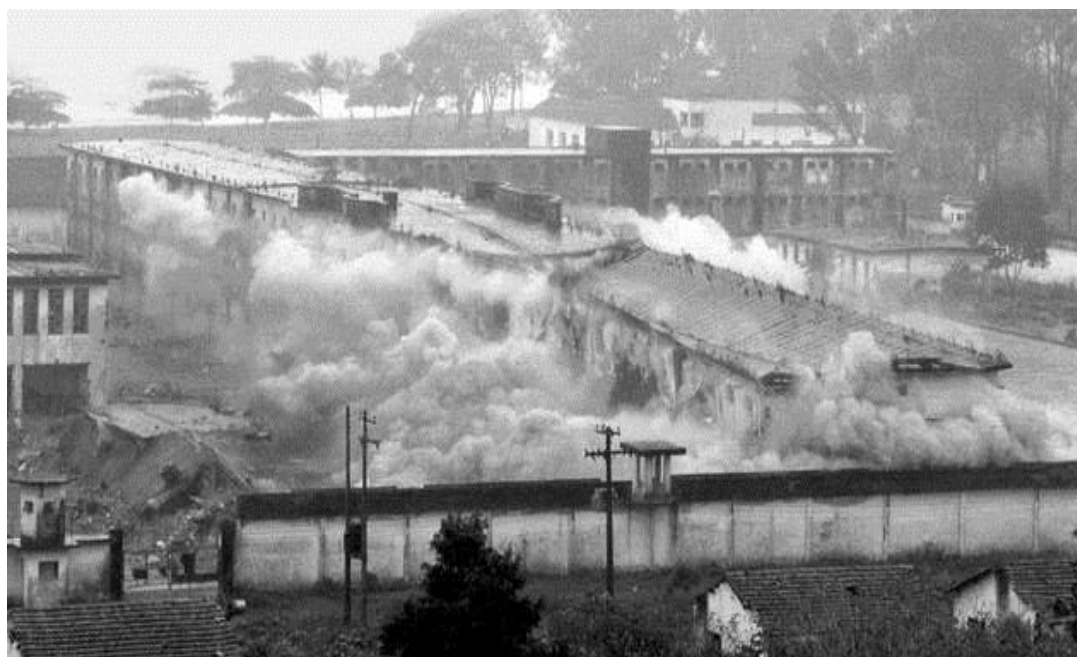
Figura 13 –Implosão da Colônia Correcional de Dois Rios
