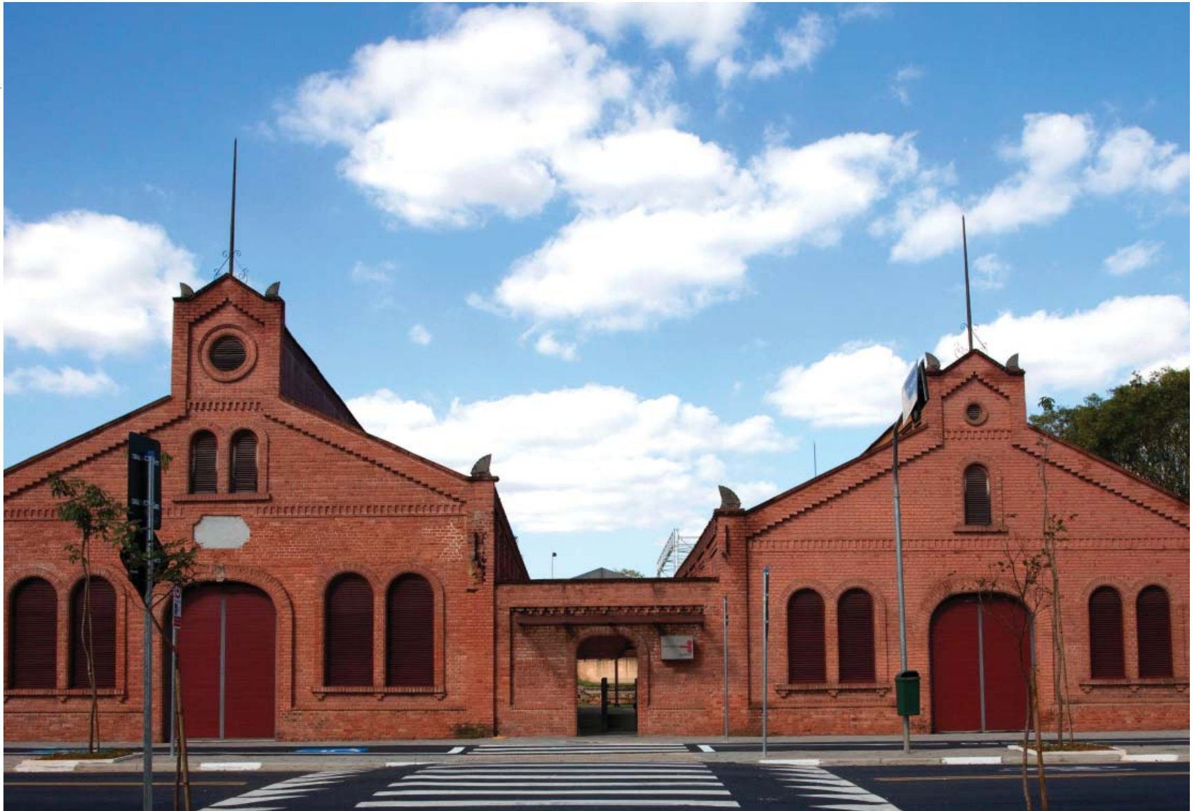
Fachada da Cinemateca Brasileira, remodelada em 2012.
