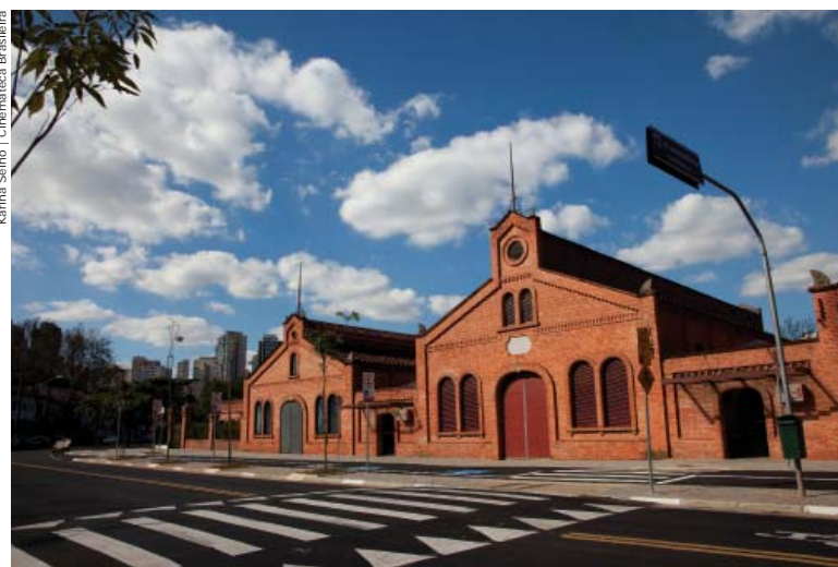
Na ordem, obras de revitalização do Largo Senador Raul Cardoso; inauguração do projeto “bike sampa” na Cinemateca; e nova fachada após a reforma.
