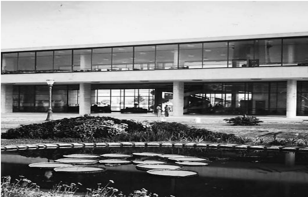
Figura 30: Frente do edifício da Estação de Hidros.
