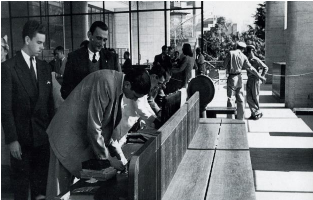
Figura 32: Embarque de passageiros da Estação de Hidros.
