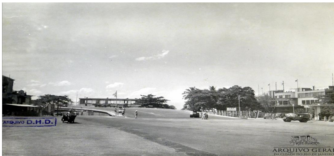
Figura 35: Construção do elevador da Perimetral e ao fundo a Estação de Hidroaviões e o COMARIII.
