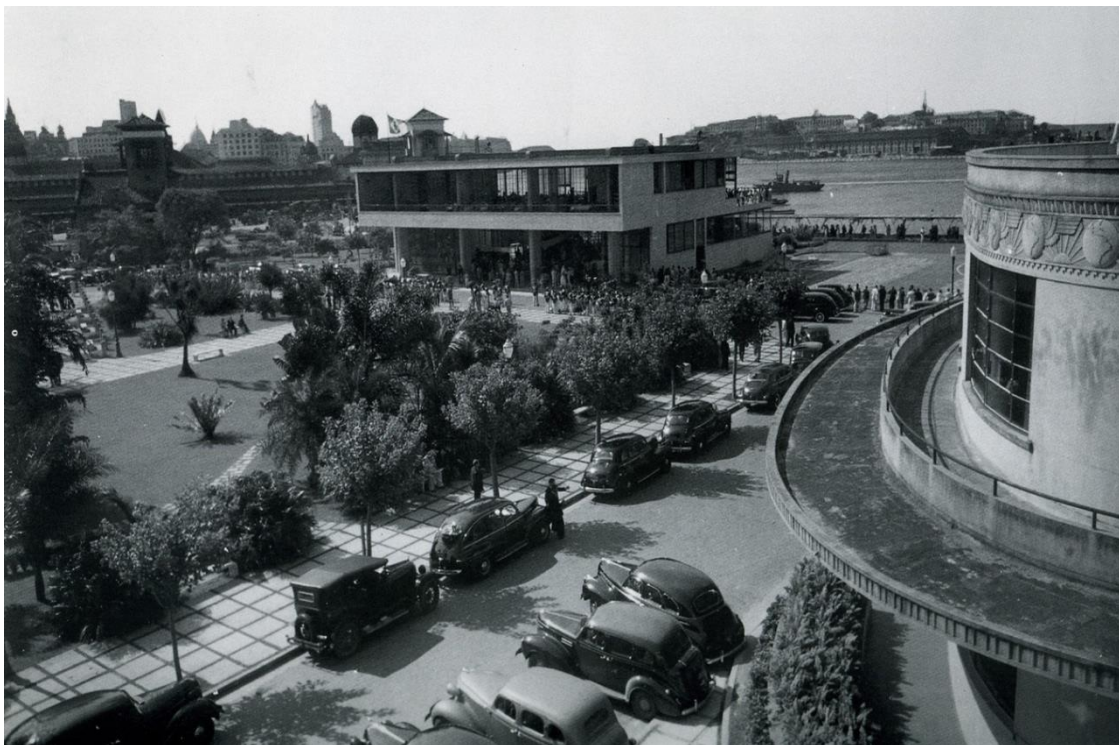
Figura 33: Estação de Hidros. Fonte:
