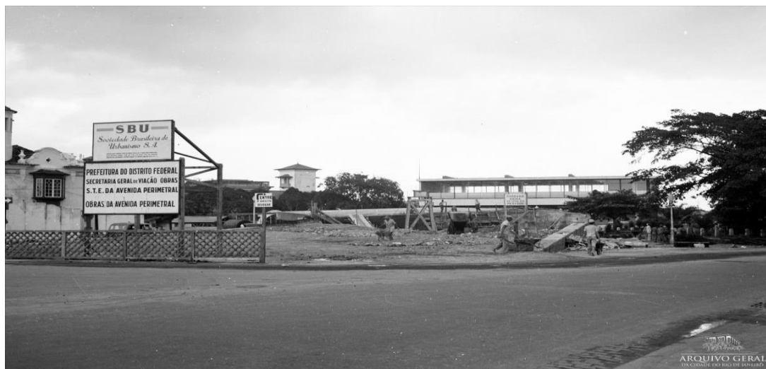
Figura 34: Construção do elevador da Perimetral e ao fundo a Estação de Hidroaviões.
